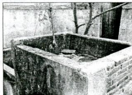
Bể chứa nước không đảm bảo vệ sinh tại Ích Hậu Ảnh: Q.L
